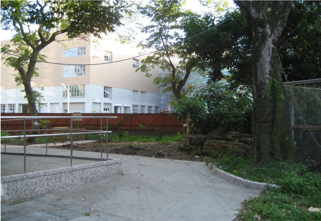
藝術館側規劃出口車道現場
